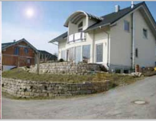
Mauersteine trocken versetzt Schichthöhe circa 25-30 cm
