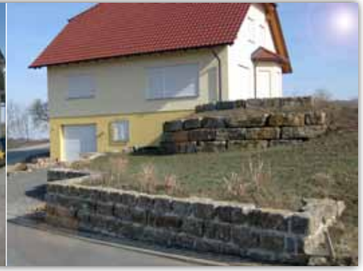
Vorne Mauersteine in Mörtel versetzt; hinten als Trockenmauer
