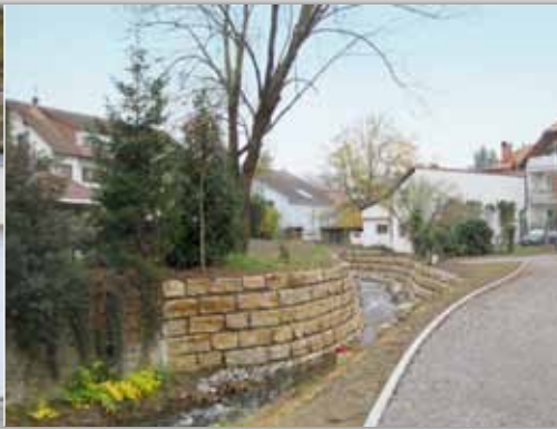
Mauersteine trocken versetzt: Gestaltung und Befestigung eines Bachlaufs
