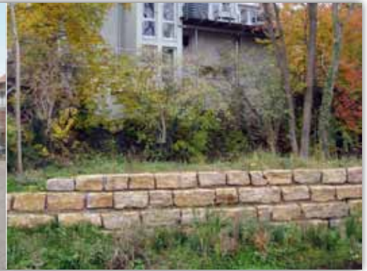
Mauersteine trocken versetzt: Gestaltung und Befestigung eines Bachlaufs
