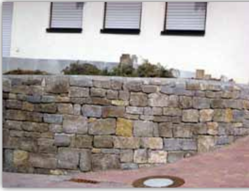
Mauersteine trocken versetzt Als Schichtmauerwerk, diverse Schichthöhen
