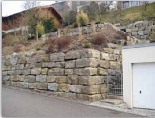
Mauersteine trocken versetzt Als Gestaltung und Schwerlastmauer
